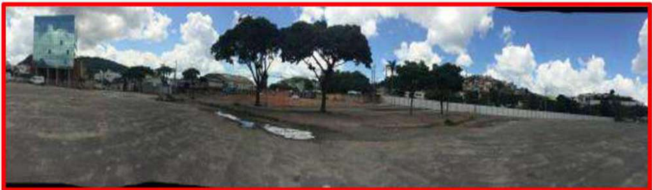
Vista geral Justiça Federal – Canteiro de obras
